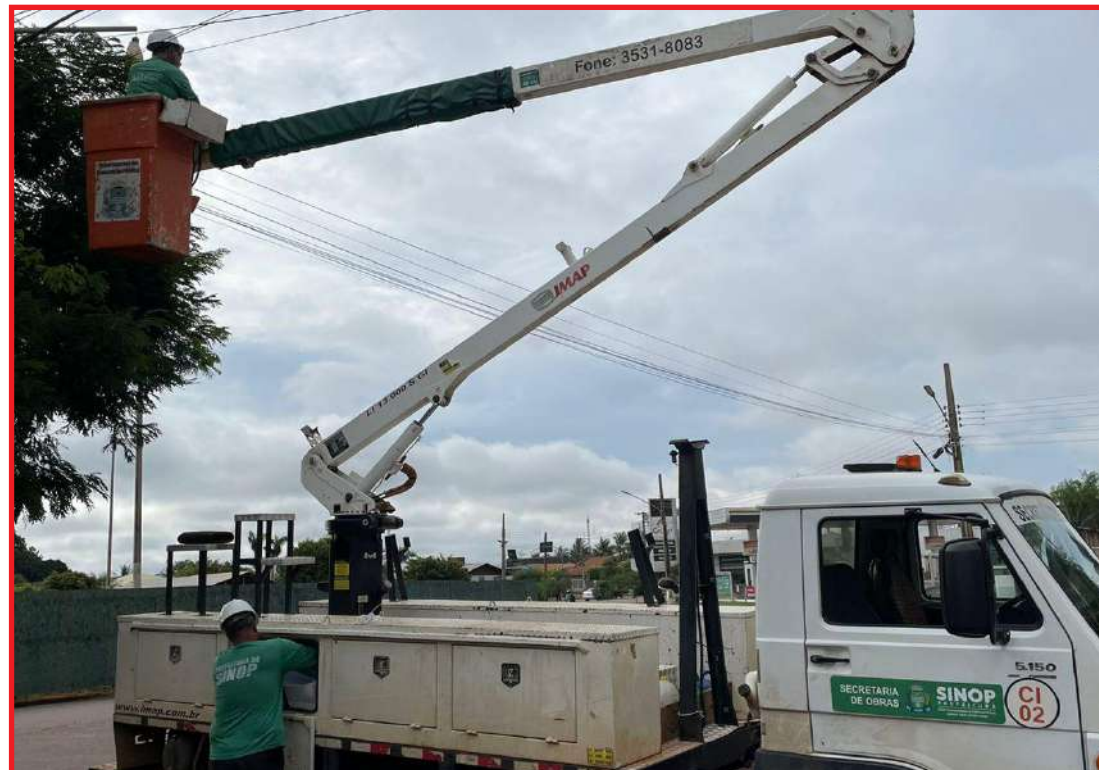
Trabalho realizado na avenida dos Jatobás
