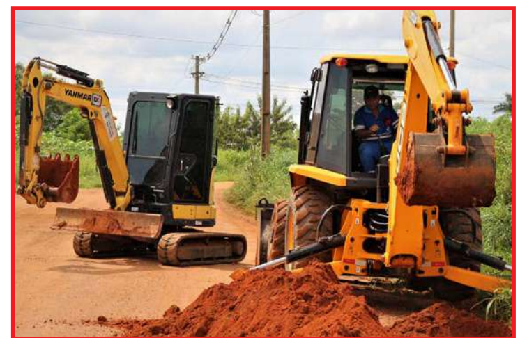
Saae está fazendo 220 metros de expansão de rede
