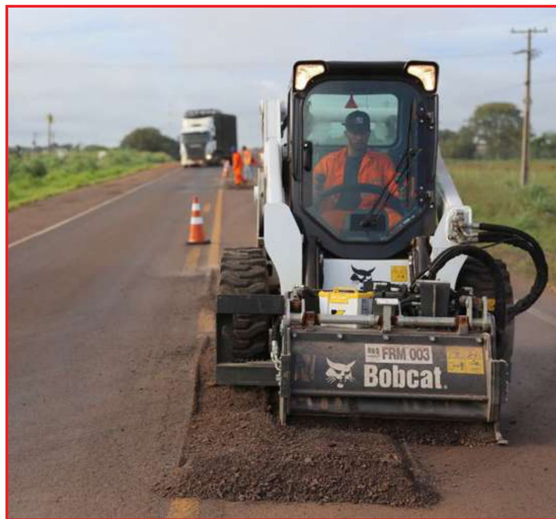
As equipes recuperaram trechos pavimentados da BR-158 próximo a Ribeirão Cascalheira
