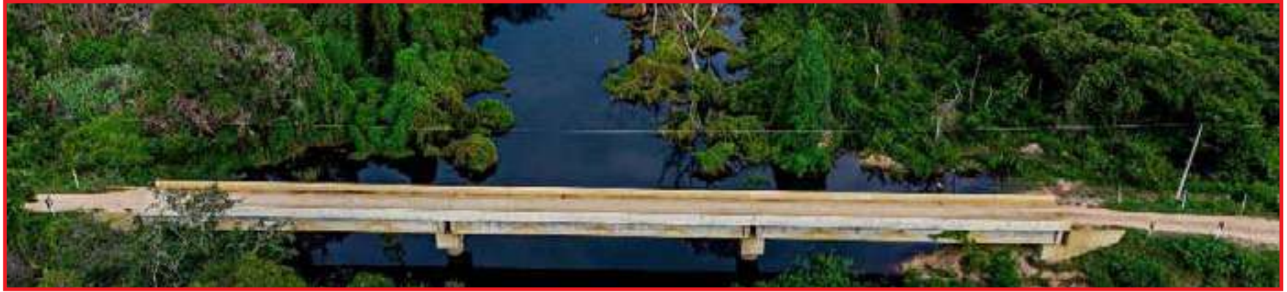
Ponte de concreto na Transpantaneira
