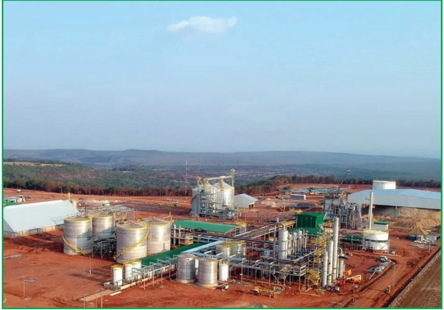
Construção do complexo em Canarana inicia no primeiro semestre desse ano
