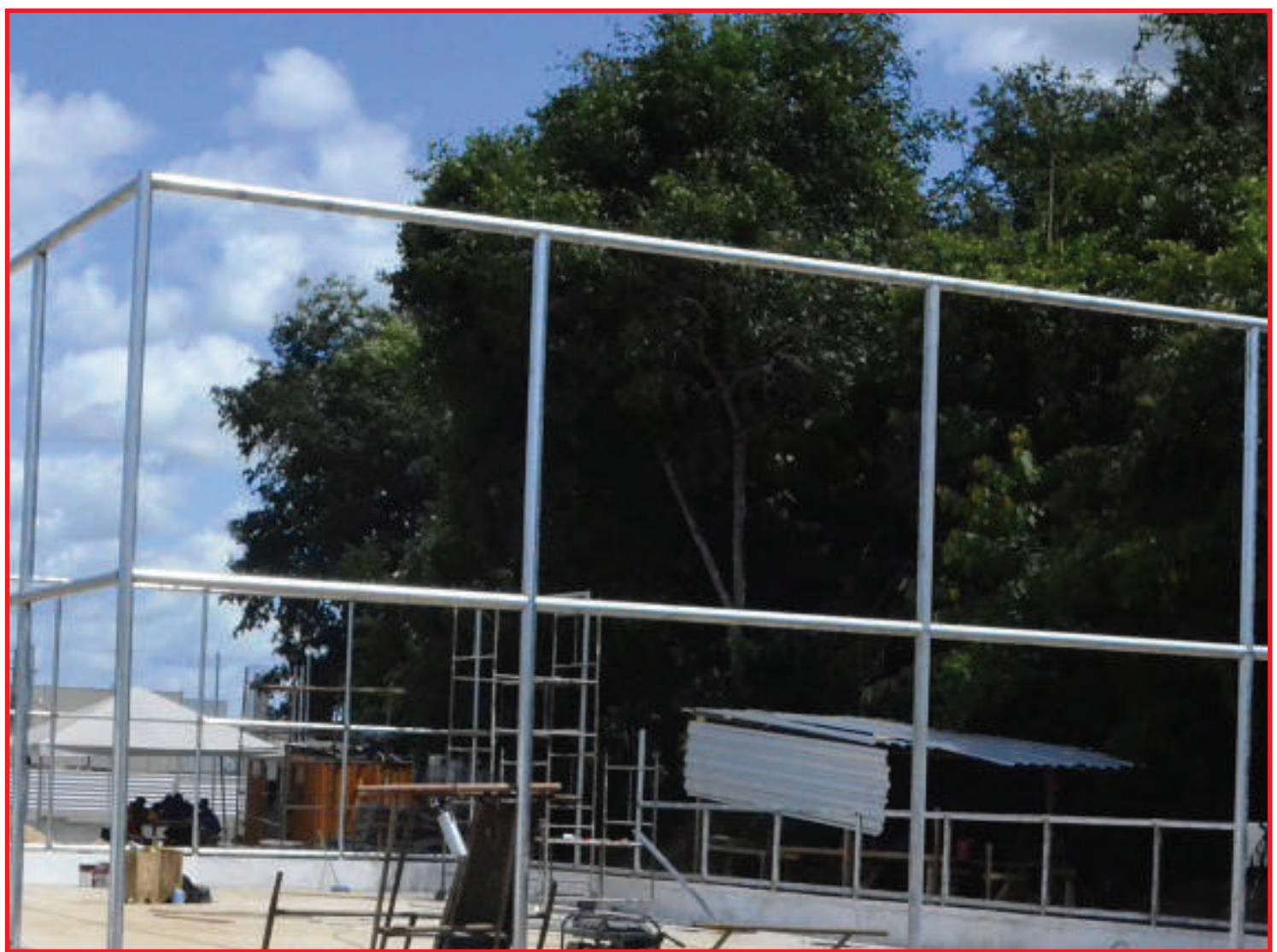
Parque está com 25% das obras concluídas
