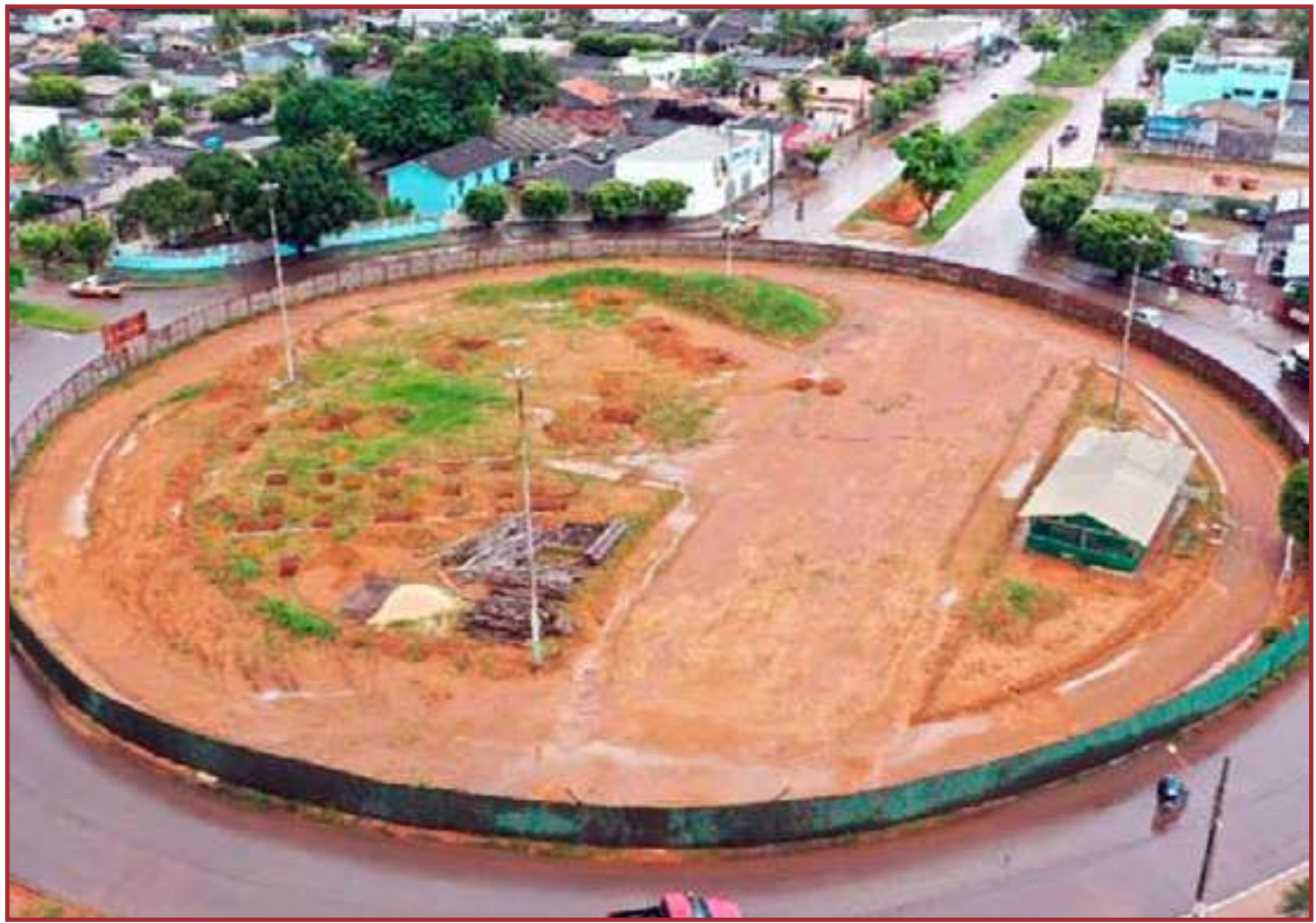
Empresa queria reajuste na verba para continuar a obras
