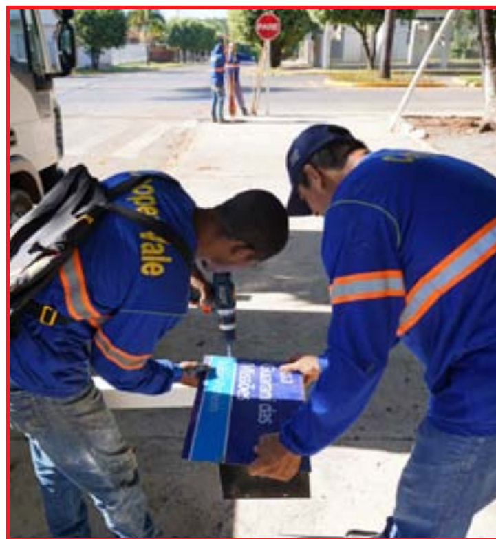
Placas de sinalização viária também foram compradas para melhorias na sinalização
