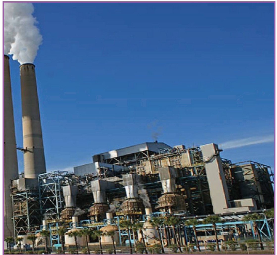
Oito usinas estão em construção, uma em teste e outra paralisada
